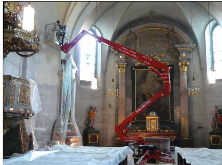
Färbelung innen mittels Hebebühne
