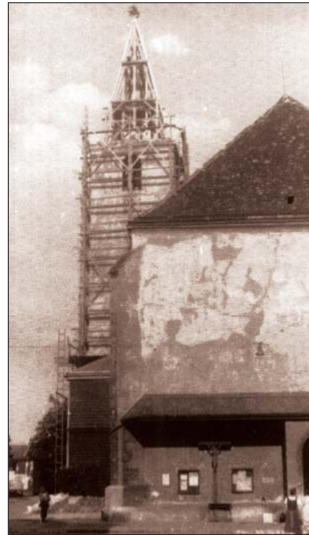
Abb. 5: Der eingerüstete Turm 1946
